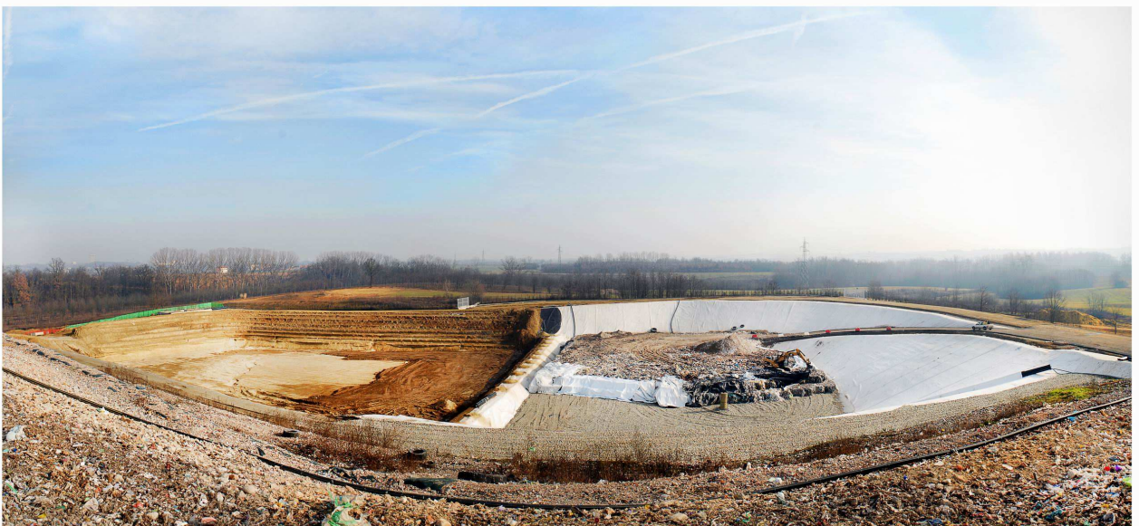
foto dei lavori in corso sulla nuova area della discarica.
